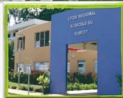
LPA du ROBERT Four à Chaux
