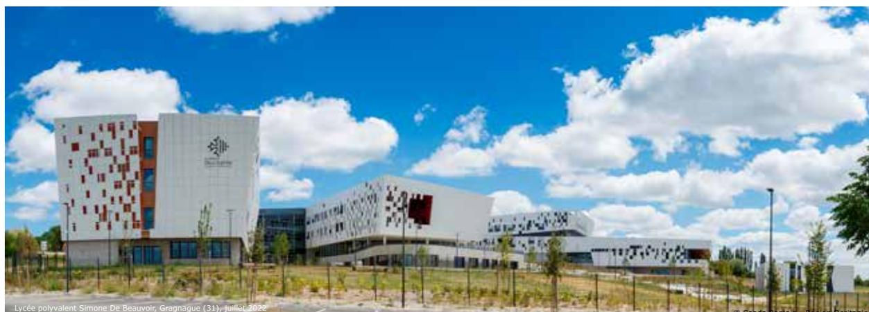
Dans une logique de réduction de son empreinte écologique, ce **lycée à énergie positive** sera **entièrement chauffé par une production géothermique** qui permettra également de refroidir le bâtiment. **2 400 m<sup>2</sup> de panneaux photovoltaïques** lui permettront de fonctionner en autoconsommation. 90% des surfaces étant par ailleurs éclairées en lumière naturelle. Près de **6000 végétaux** seront également plantés sur l'ensemble du périmètre de l'établissement.
