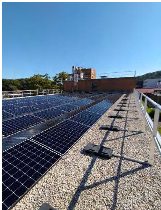
Le toit du lycée de Mouchard (Jura)
